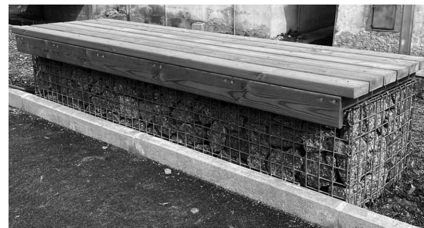
Figura 330. Imatge de referència de banc de fusta sobre muret de gabions.
