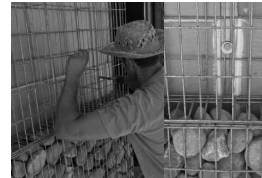
3-Col·locació de gabió a la paret i clavat amb cargols.
