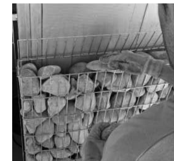
4-Reomplert del gabió amb pedres.
